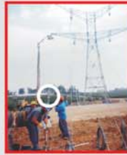
Измерение натяжения кабелей
